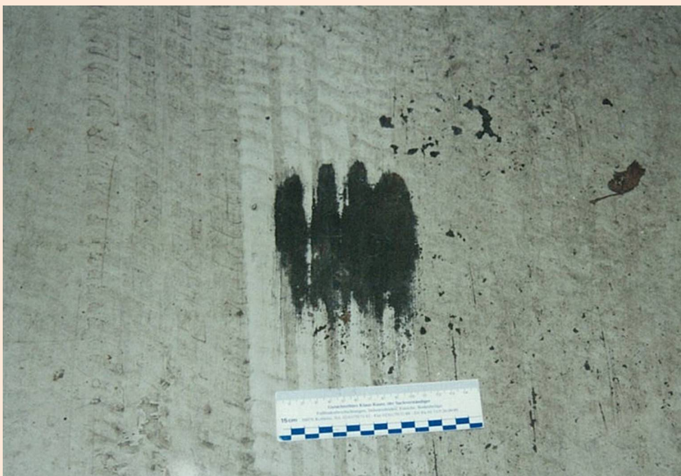
Foto 3 Abrieb durch Antriebs- räder
