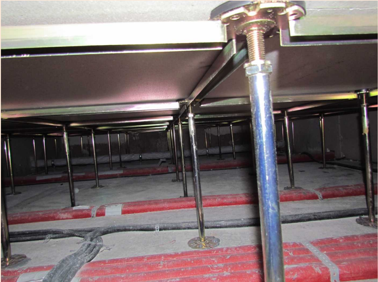
Foto 3 U-Profile zur Stabilisierung der Gesamtkonstruktion
