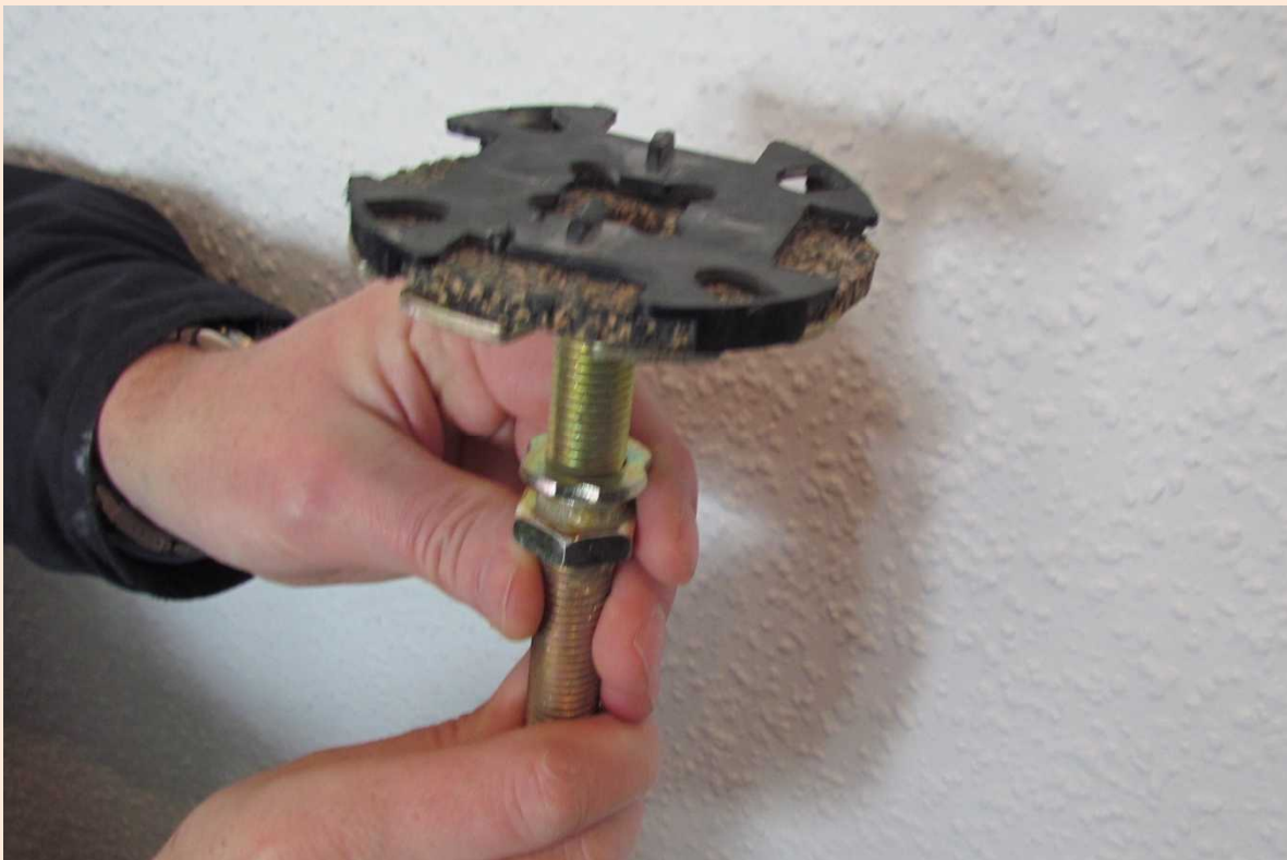
Foto 1 Stütze mit Gewinde und Befestigungsmuttern; die elastische Unterlage am Auflageteller entkoppelt Stütze und DoBo-Element
