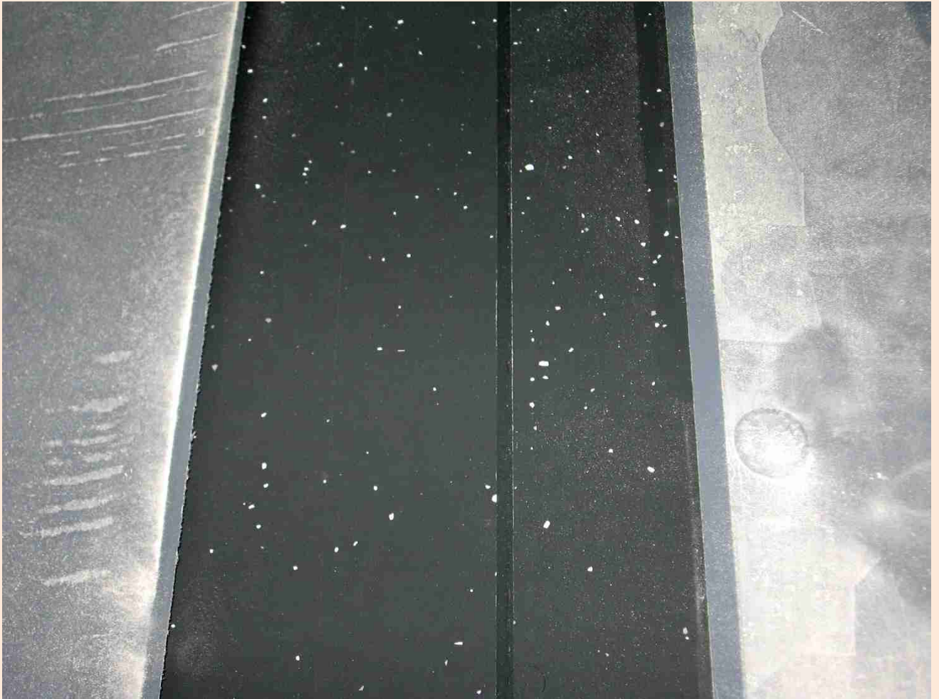
Foto 9 fertiggestellte Bewegungsfuge (links- und rechtsseitig ist noch die Schutzfolie aufgelegt)
