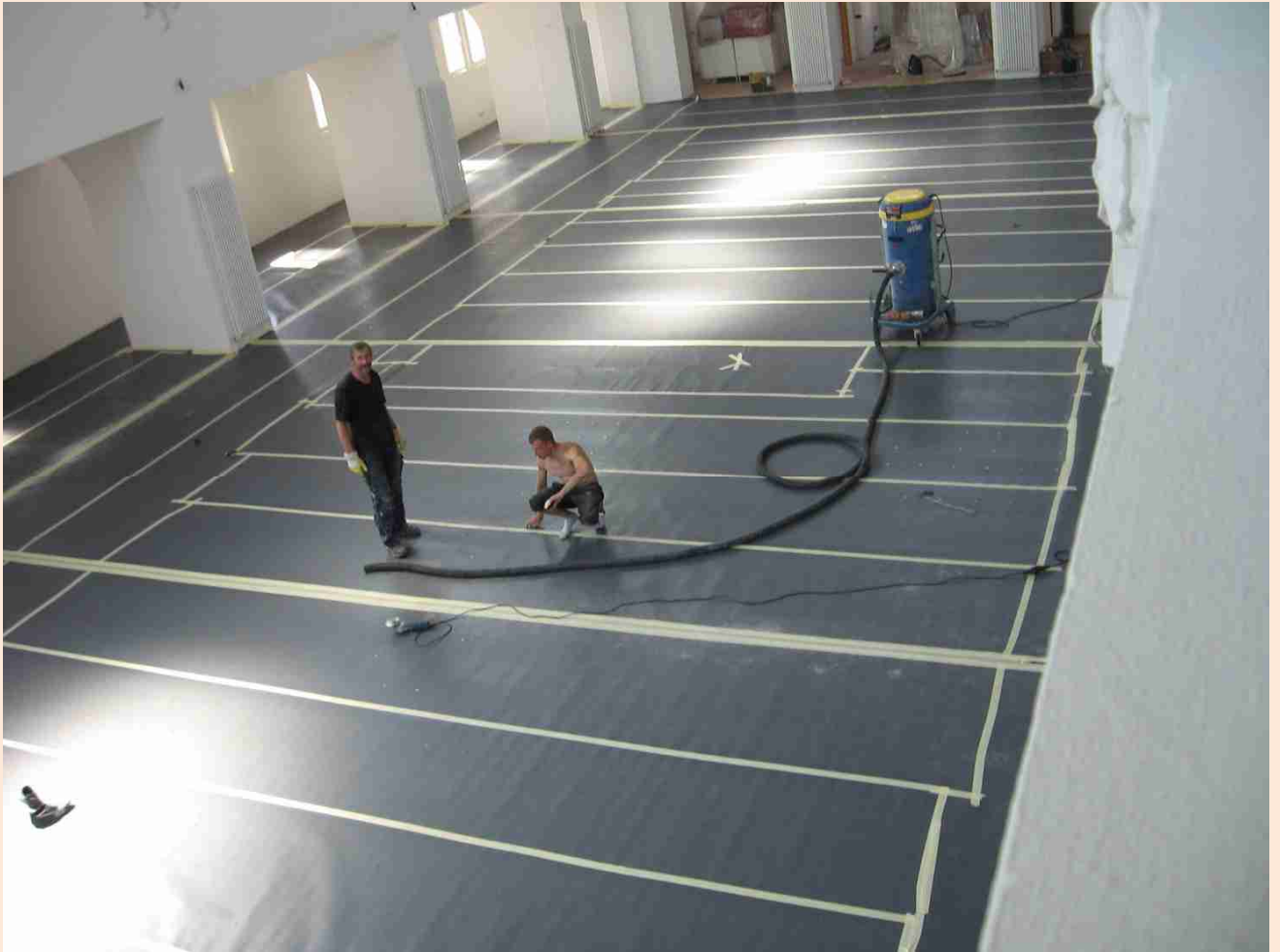
Foto 6 abgedeckte Beschichtung, vorbereitende Arbeiten für die Fugenschnitte
