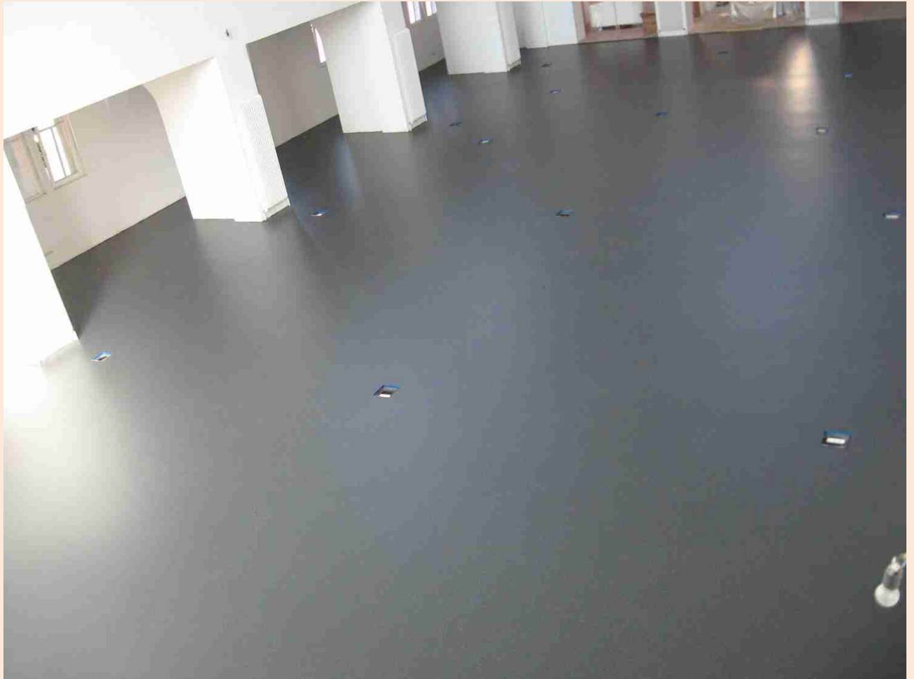
Foto 5 nahezu fertiggestellte Fußbodenbeschichtung. Die Markierungen zeigen den Verlauf der (zu übernehmenden) Fugenverläufe aus dem Untergrund an
