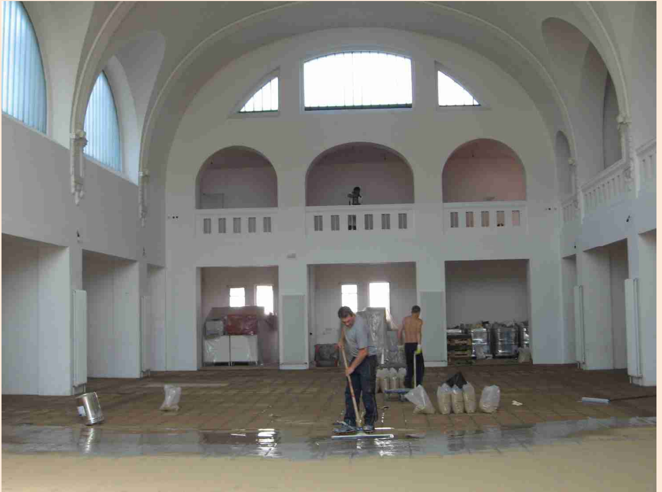
Foto 1 die Grundierung wird mit Gummiwischern aufgezogen
